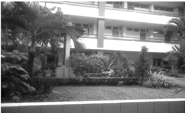
Gambar 8. Gedung M kampus UNJ setelah bersih dari banjir
